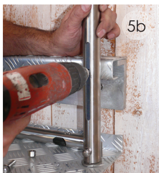
5b Version VF1&2: Faites un trou dans le plastique du fuseau. Tenez celui-ci bien vertical.
