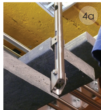
4a Version VF3: Attachez le fuseau au set de fixation inférieur.
