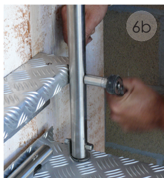
6b Version VF1&2: Attachez le fuseau contre l'élément supérieur du set de fixation.
