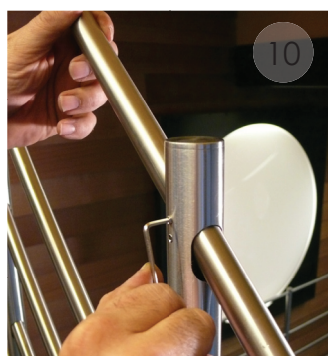
10 Passez les lisses dans les fuseaux et fixez-les.
