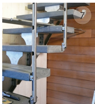
7 Vérifiez que l'ensemble est bien droit.
