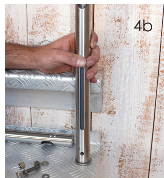
4b Version VF1&2: Attachez le fuseau au set de fixation inférieur.
