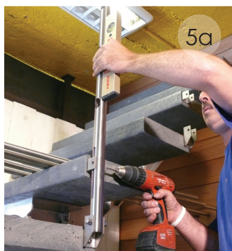
5a Version VF3: Faites un trou dans le plastique du fuseau. Tenez le tout bien vertical.
