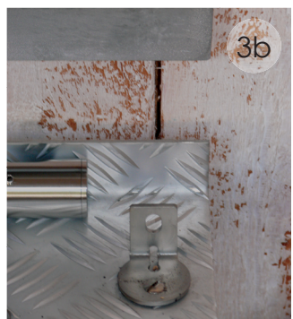
3b Version VF1&2: Vissez l'élément de fixation sur la marche.
